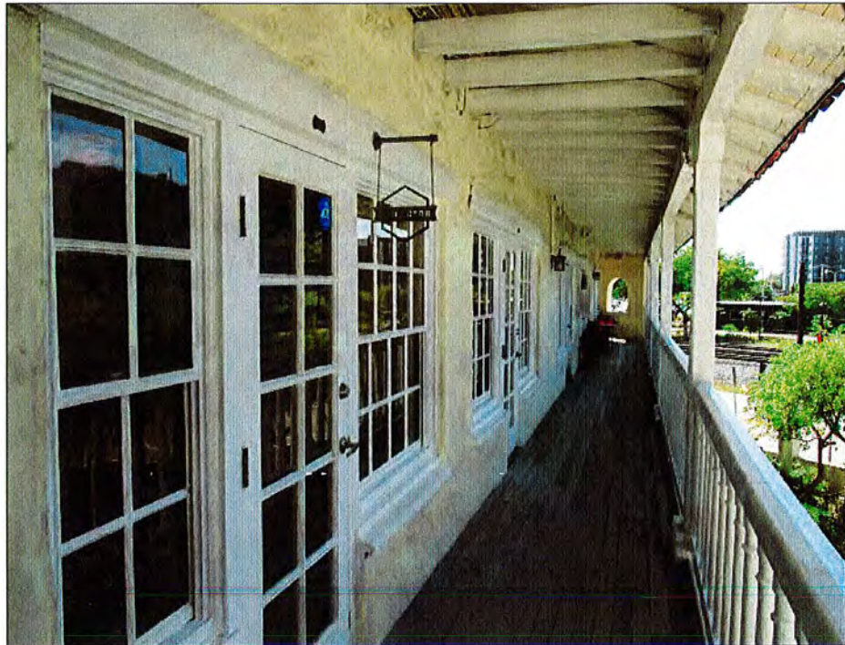
SECOND FLOOR HALLWAY AND TENANT SPACE
