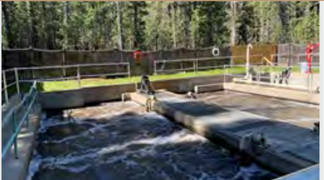
Tuolumne Meadows WWTP
